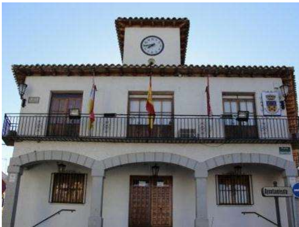
Fachada del Exmo. Ayuntamiento de Huerta de Valdecarábanos. Foto: Víctor M. Villafuertes Luján.
