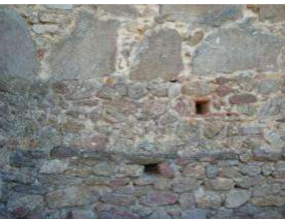
Hiladas de los muros
