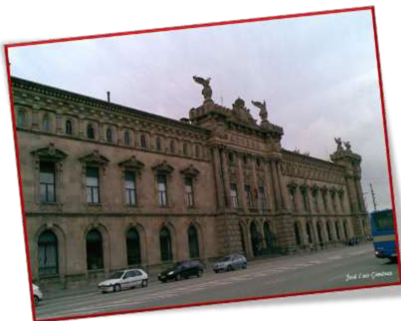
Edificio de la Aduana de Barcelona - Leones alados y águila imperial.
